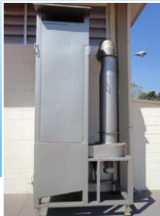
Central de exaustão de fumaça de solda. Projeto desenvolvido para o SENAI e para a fundação Shunji Nishimura.
