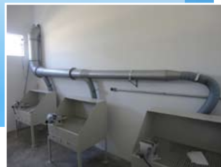
Central de exaustão de fumaça de solda. Projeto desenvolvido para o SENAI e para a fundação Shunji Nishimura.
